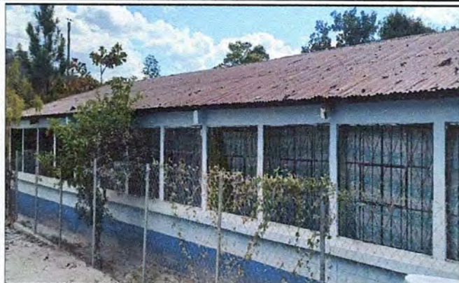
Foto 1: TECHO DE LAMINA
